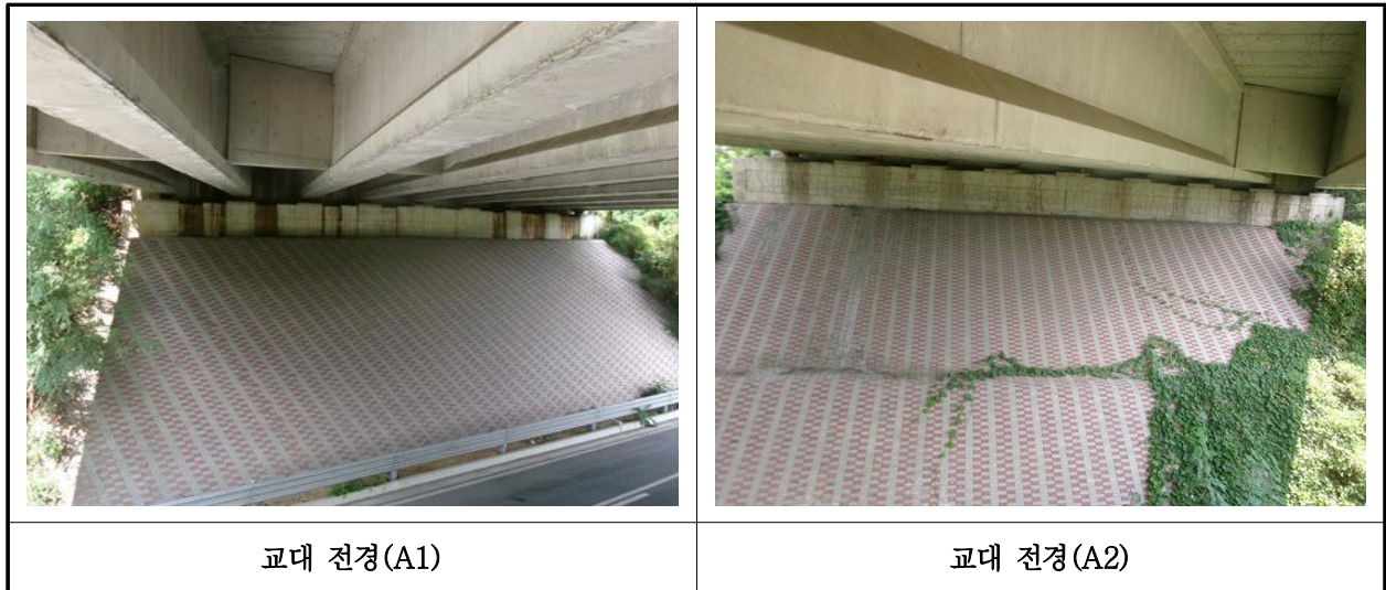
【사진 9.3.8】 교대 전경
