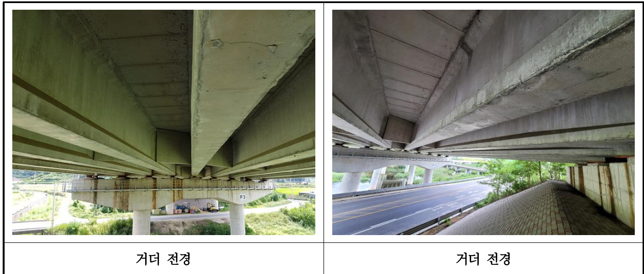
【사진 9.3.4】 거더 전경
