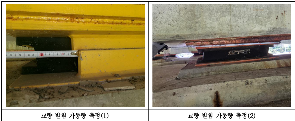
【사진 9.3.16】 교량받침 이동량 측정
