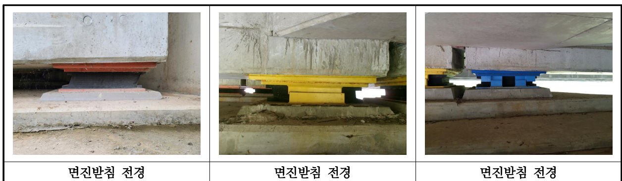
【사진 9.3.13】 교량받침 전경
