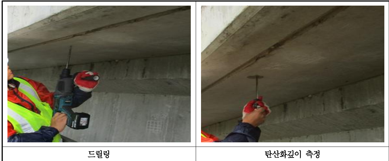
【사진 9.4.3】 탄산화 깊이 측정 현장사진
