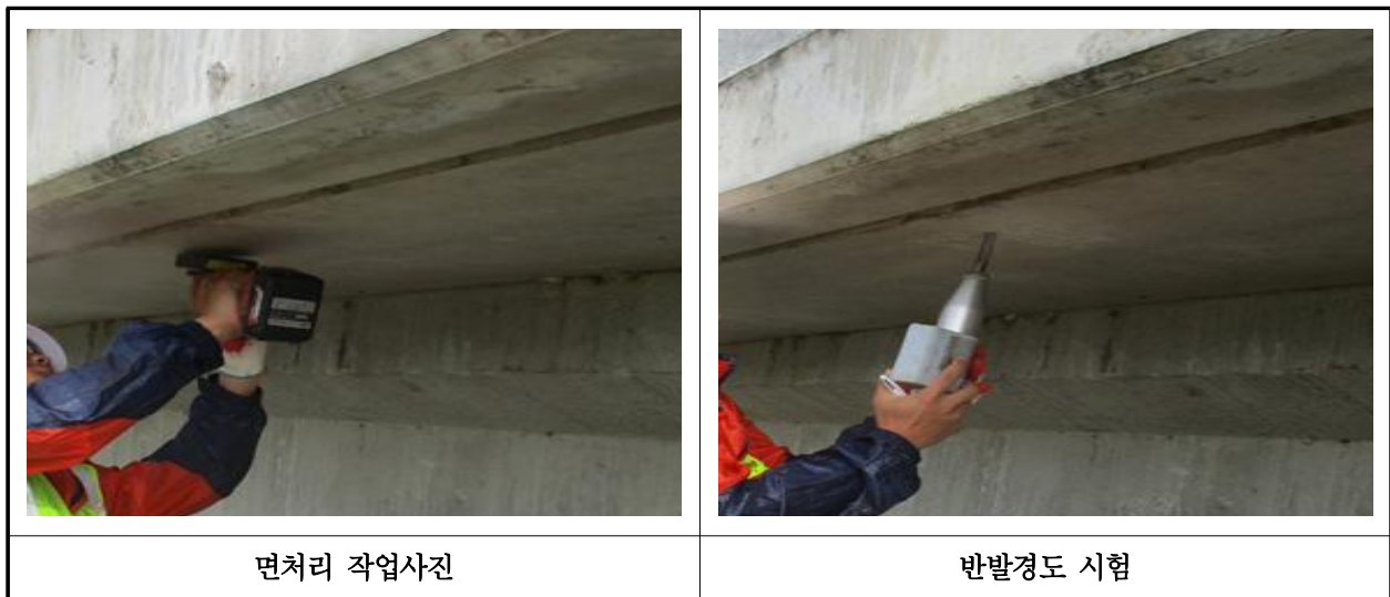
【사진 9.4.2】 반발경도시험 현장사진
