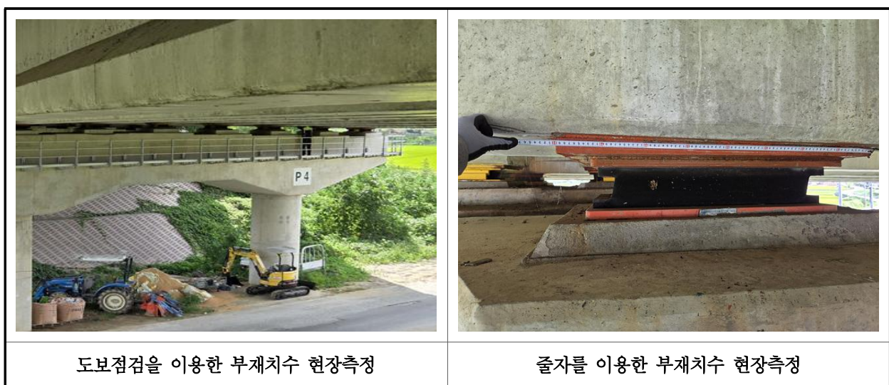
【사진 9.2.1】 부재 현장측정 전경
