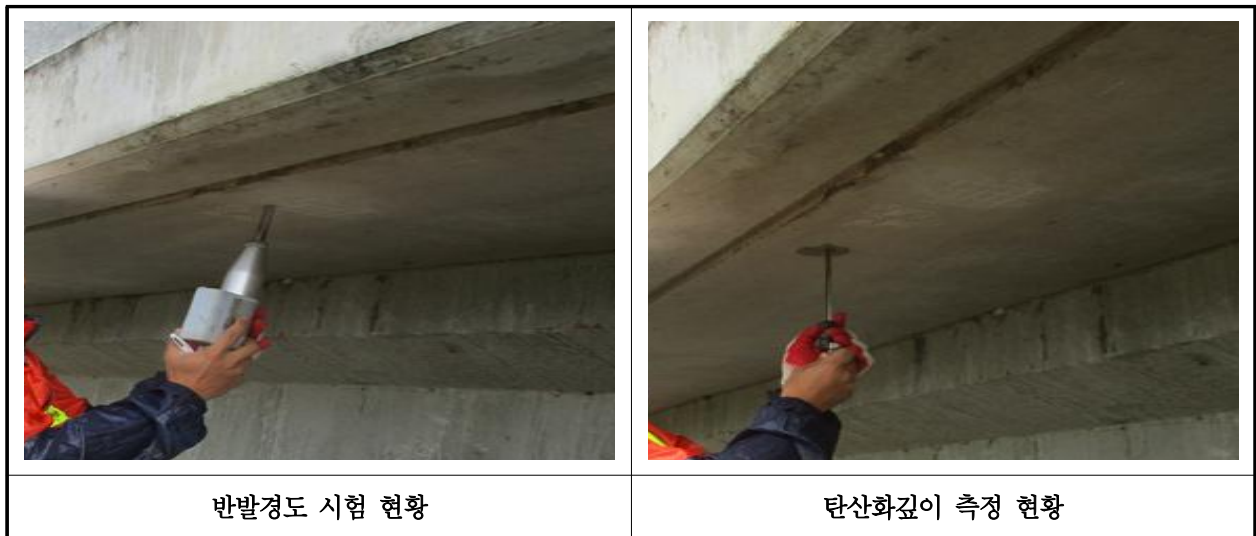
【사진 9.4.1】 콘크리트 내구성조사 현황
