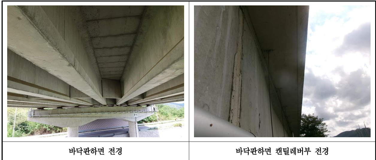
【사진 9.3.2】 바닥판하면 전경
