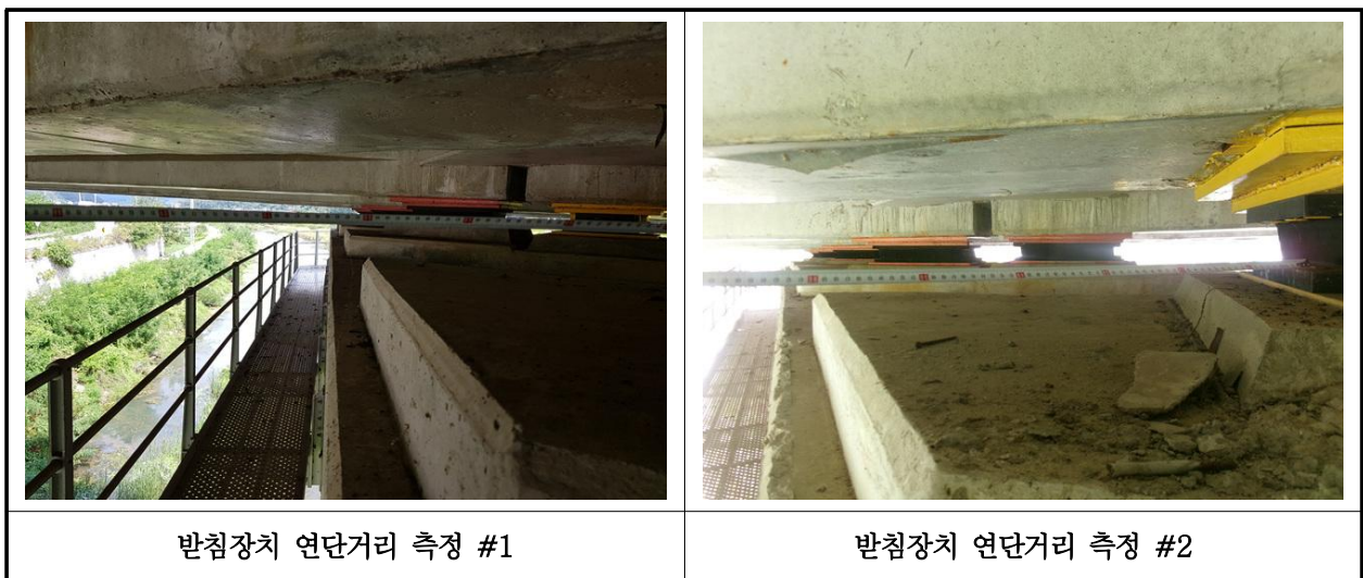
【사진 9.3.15】 교량받침장치 연단거리측정
