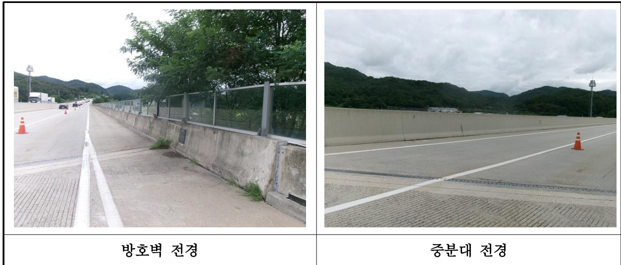
【사진 9.3.24】 방호벽 및 중분대 전경
