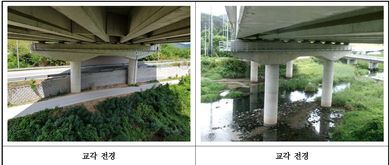
【사진 9.3.10】 교각 전경
