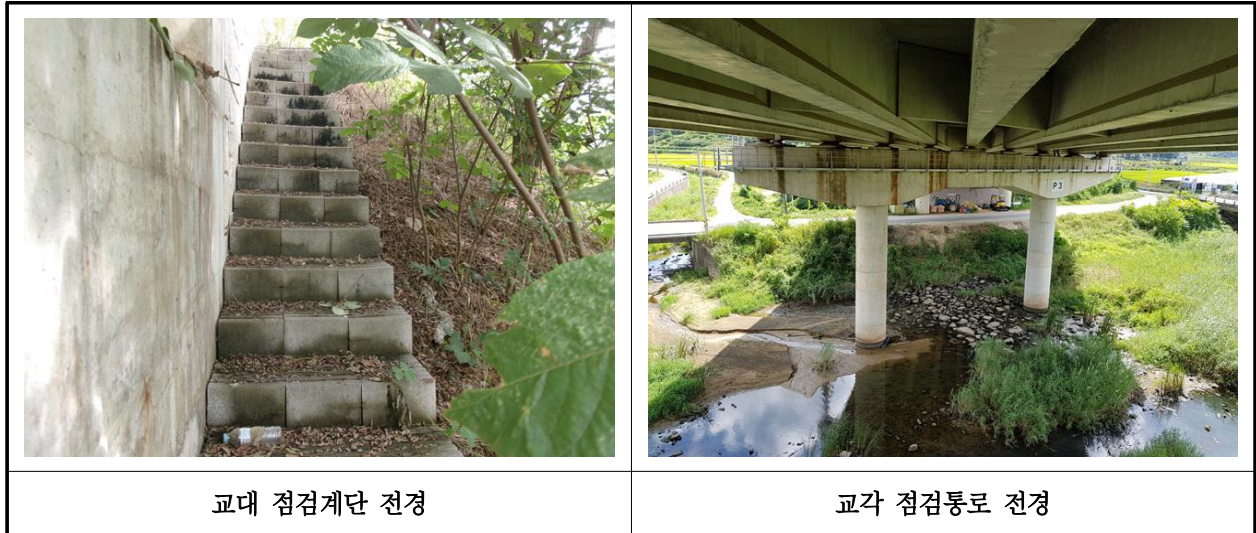
【사진 9.3.26】 교량 점검시설 전경
