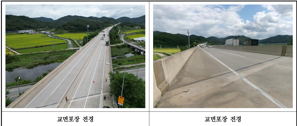
【사진 9.3.20】 교면포장 전경
